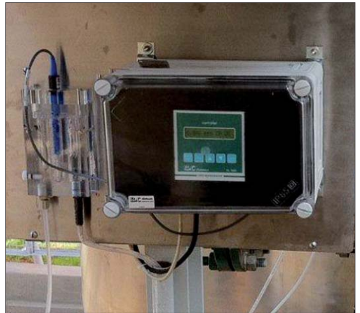
控制器 CL 7685 和流通槽 SZ 7231 的典型安装示例
