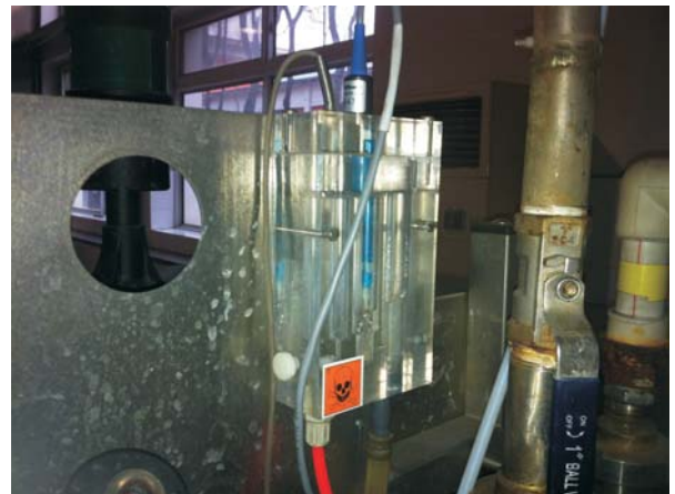
自带流通槽的旁路安装
