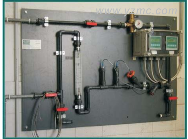
在线插入式探头的典型安装
