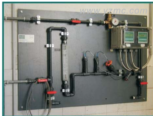
在线插入式探头的典型安装
