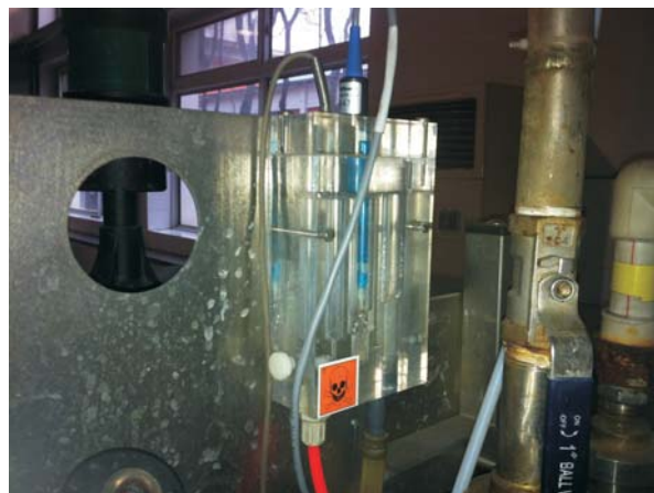
自带流通槽的旁路安装
