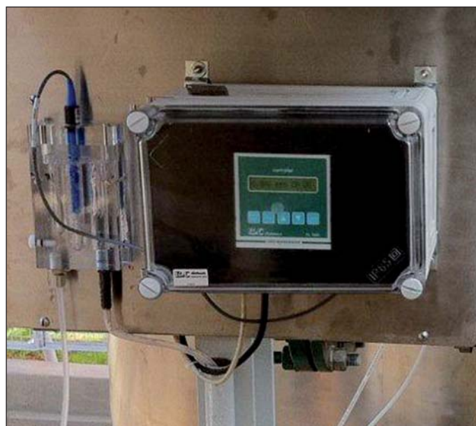
控制器 CL 7685 和流通槽 SZ 7231 的典型安装示例
