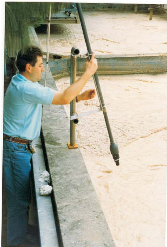
自清洗沉入探头的典型安装
