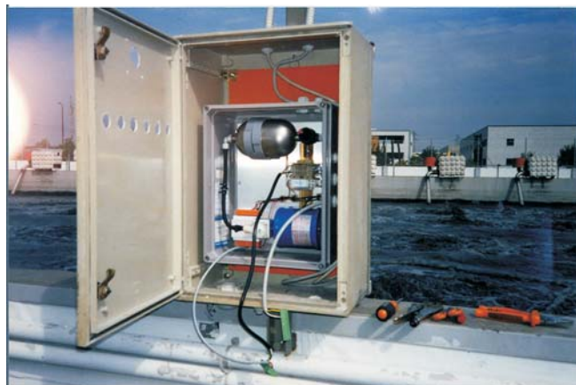
自带自清洗压缩空气的典型安装
